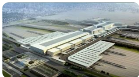
上海虹桥综合交通枢纽
